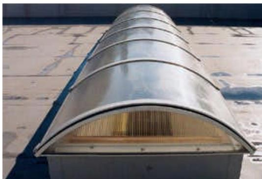
C'est qu'un skydôme peut supporté une charge de 80 à 90 kg (norme réglementaire) et que 60% de la sécurité en amont en tenant compte des risques d'intempéries encadrent les mesures de sécurité qui devraient être mise en place dans tous les magasins.
